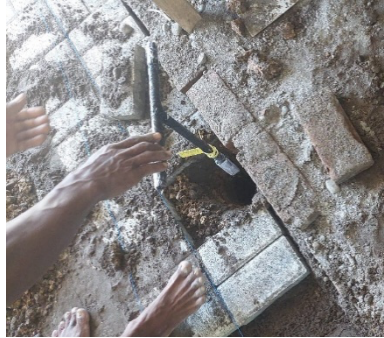
Gambar 8 Pembuatan Lubang Biopori (sumber: Dokumentasi Penulis)
