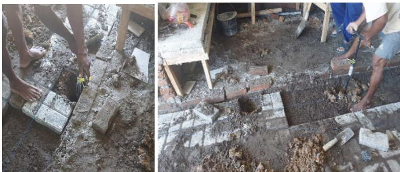
Gambar 5 Proses Penggalian (sumber: Dokumentasi Penulis)
